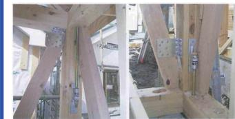
直下型地震時などにおける柱の引き抜き防止に極めて有効で、住まいの強度はさらにアップします。
