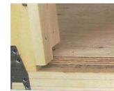
床構造には大引きと呼ばれる材を 90 mm 間隔で網の目状に配し、その上に 24 mm 厚の構造用合板を敷き込んだ「剛床工法」を採用。
